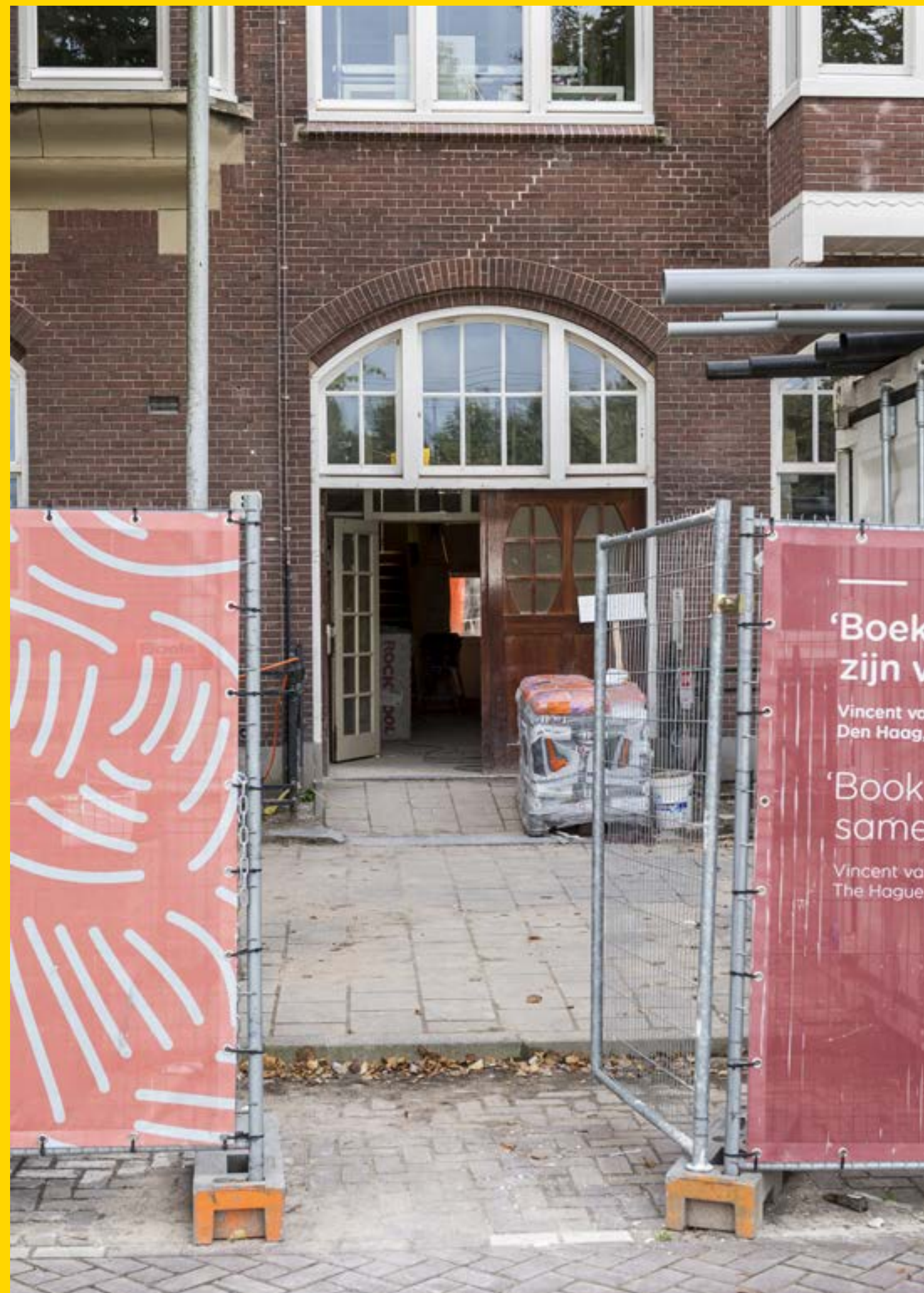
De verbouwing van het pand aan de Gabriël Metsustraat in volle gang
